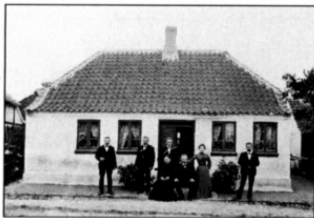
Pouls mor, hendes forældre og søskende ved huset på Hovedvejen.
